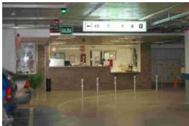
Zona de pago en el parking de Salitre (Málaga)
