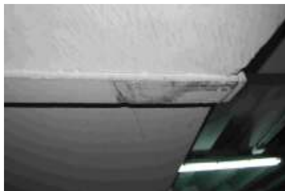
Detalle de daños producidos en el techo por el exceso de altura de un vehículo
